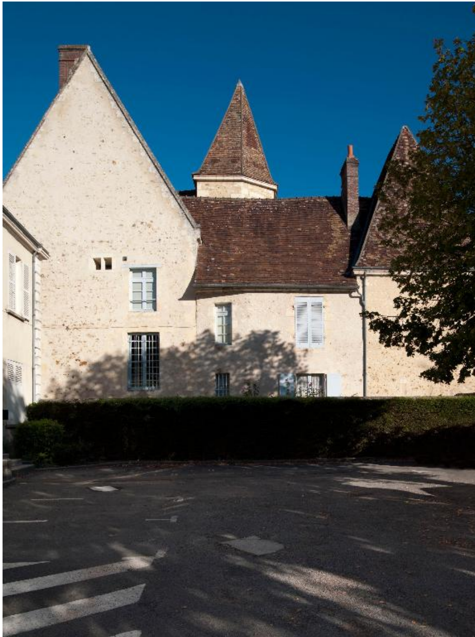
Façade ouest, vue de l'ouest.
