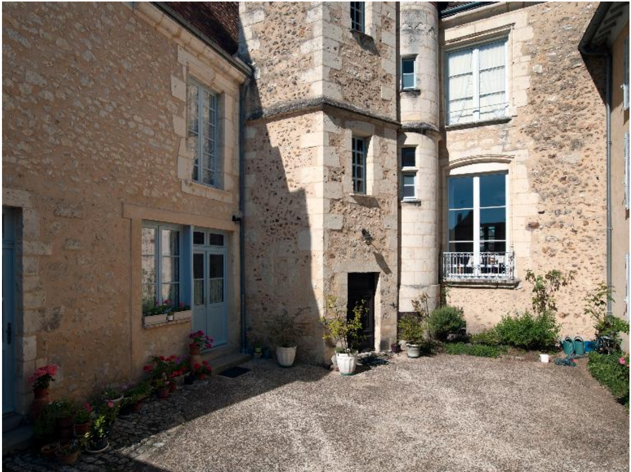
Façades sud et est, vue du sud-est.
