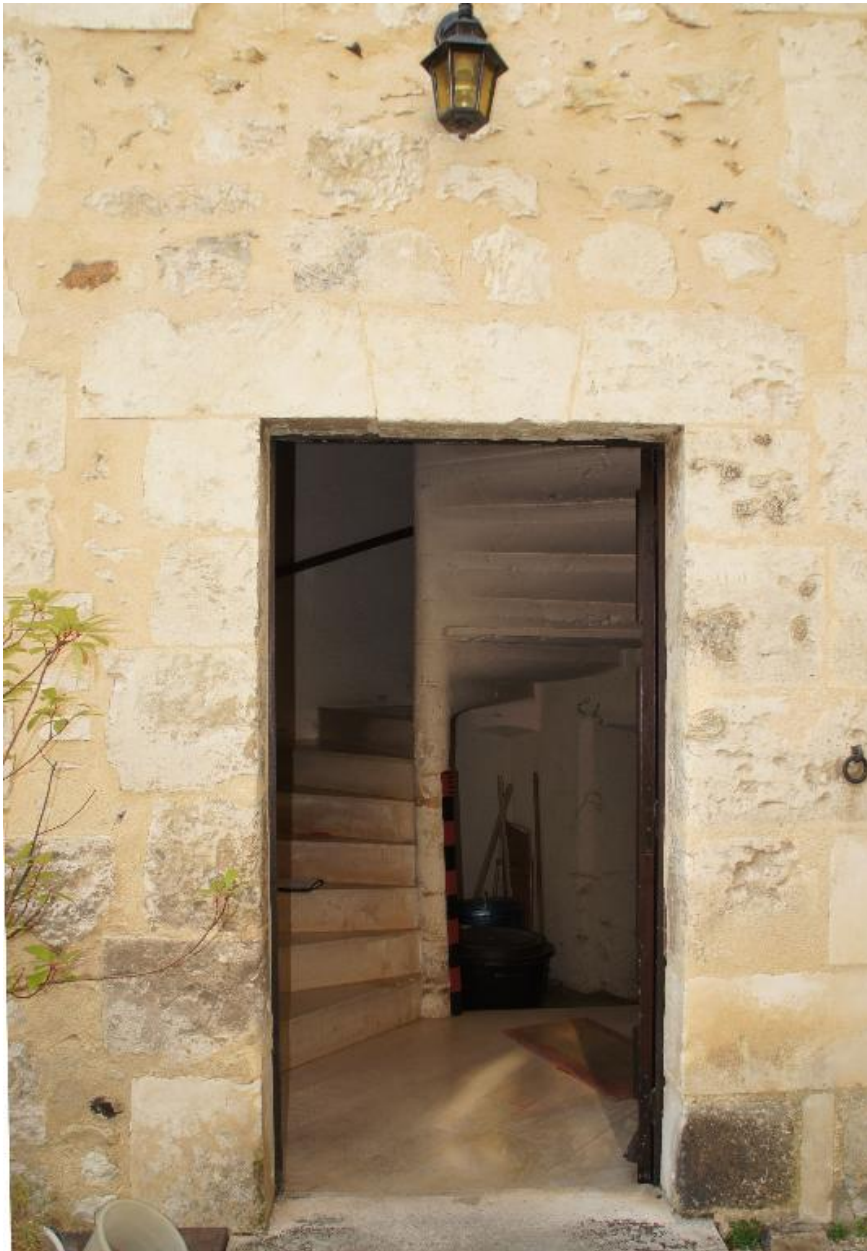
Vue intérieure, niveau 1, détail de l'escalier du bâtiment 3.
