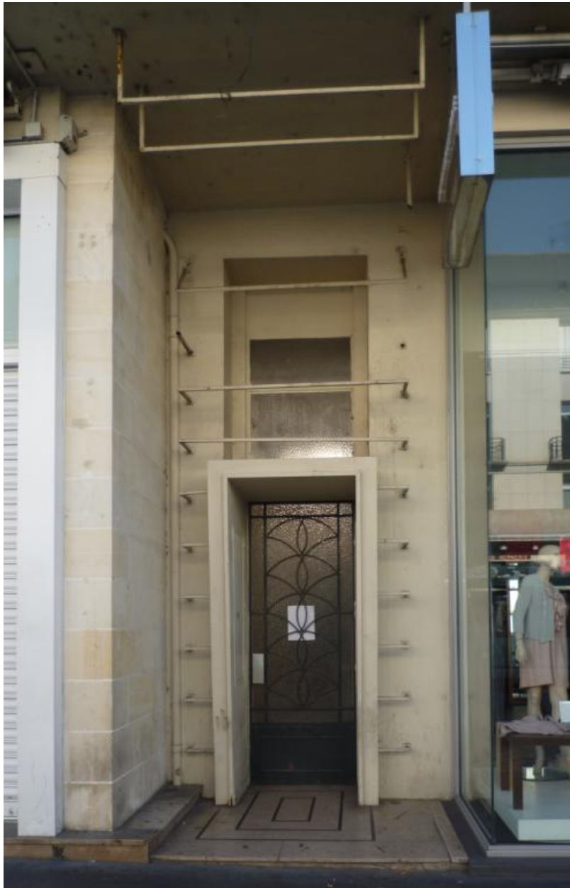
Porte d'entrée du 62 rue Nationale (îlot I).
