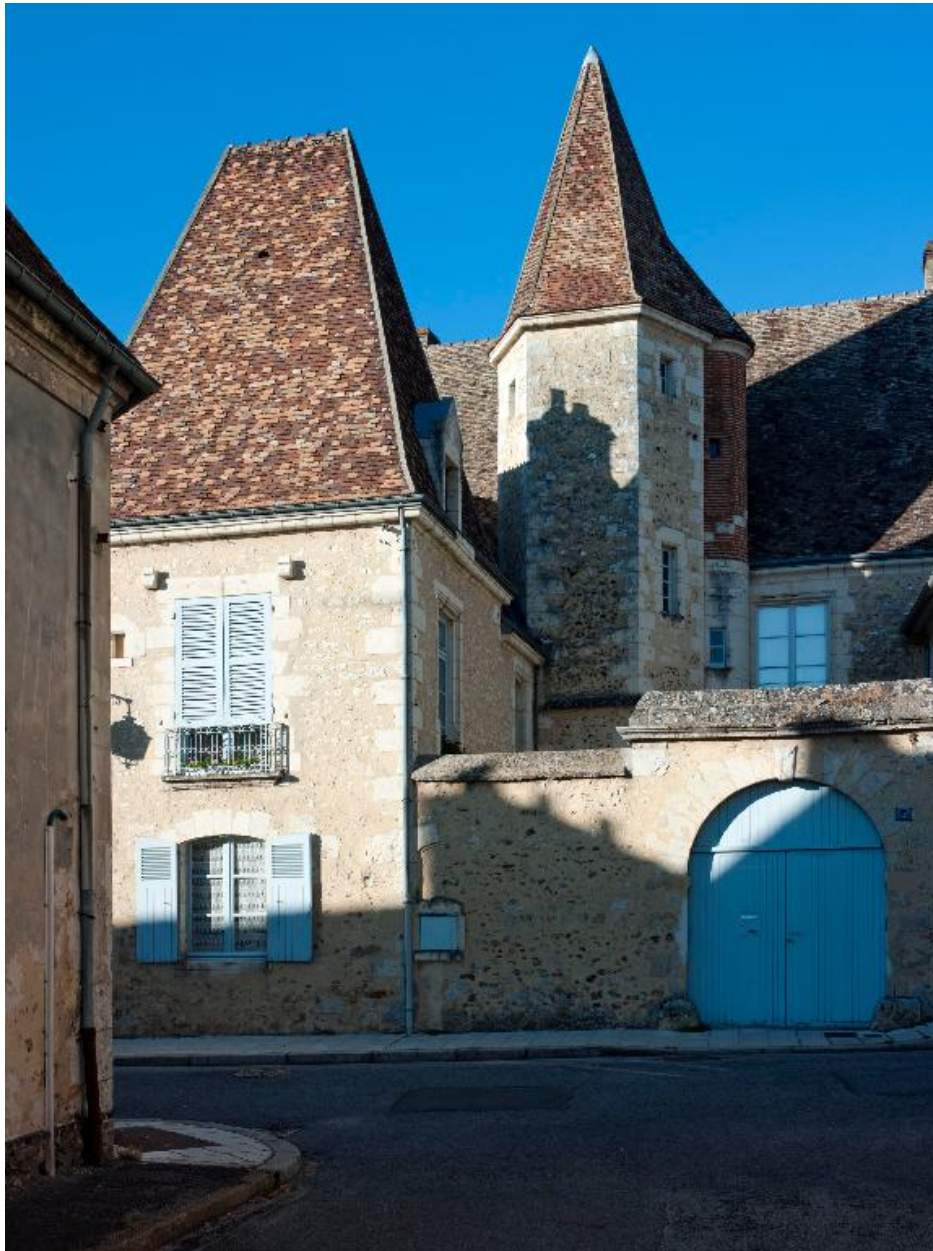
L'hôtel avec portail sur rue (type 1a), tourelle d'escalier, 2 rue Bourg-le-Comte.
