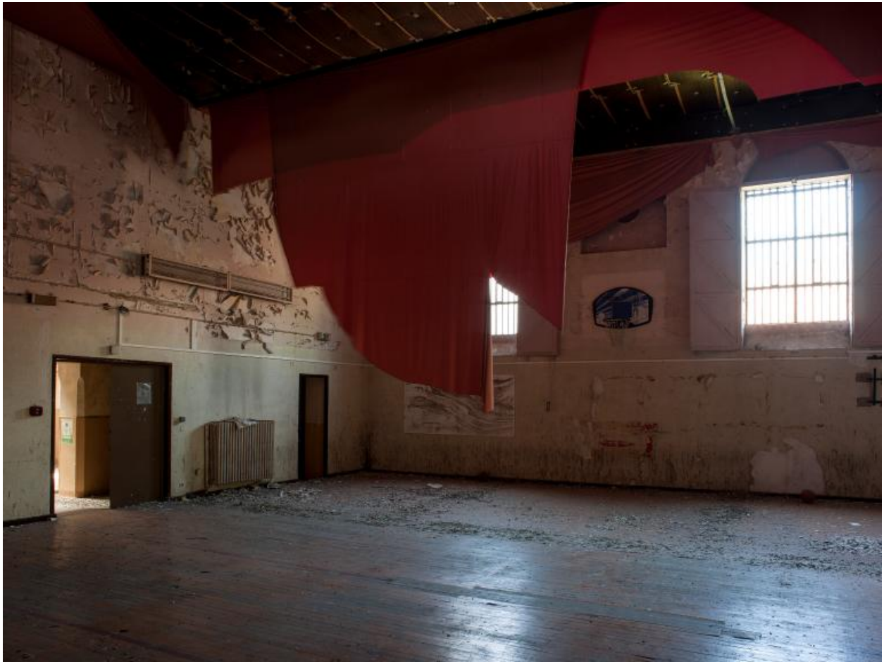
Vue intérieure du gymnase située au premier étage de l'aile nord du bâtiment principal.
