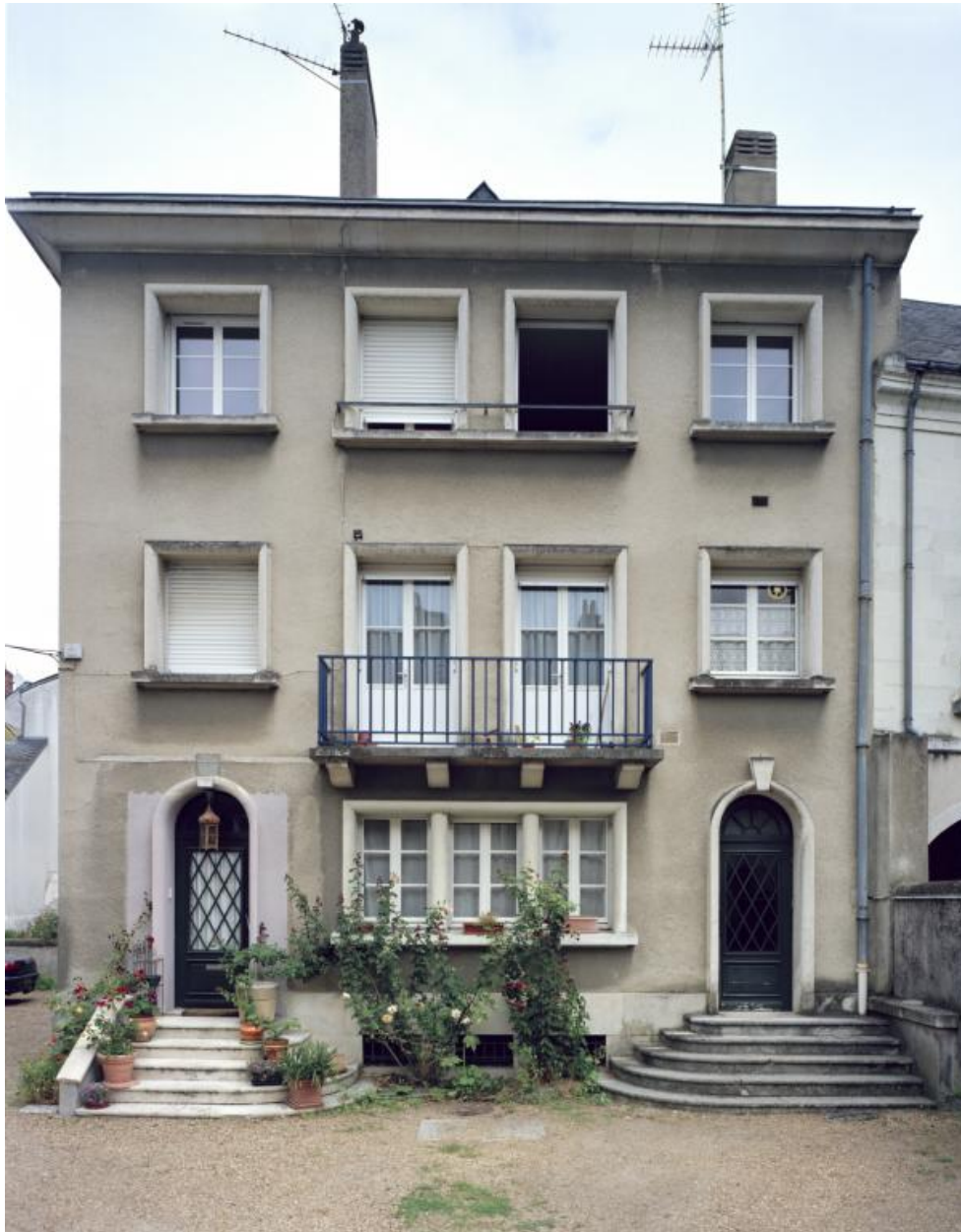
Façade principale vue depuis la cour.
