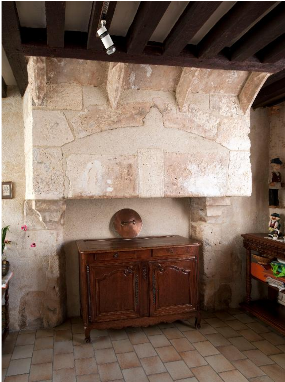
Vue intérieure, niveau 1, détail de la cheminée, salle 2.1.
