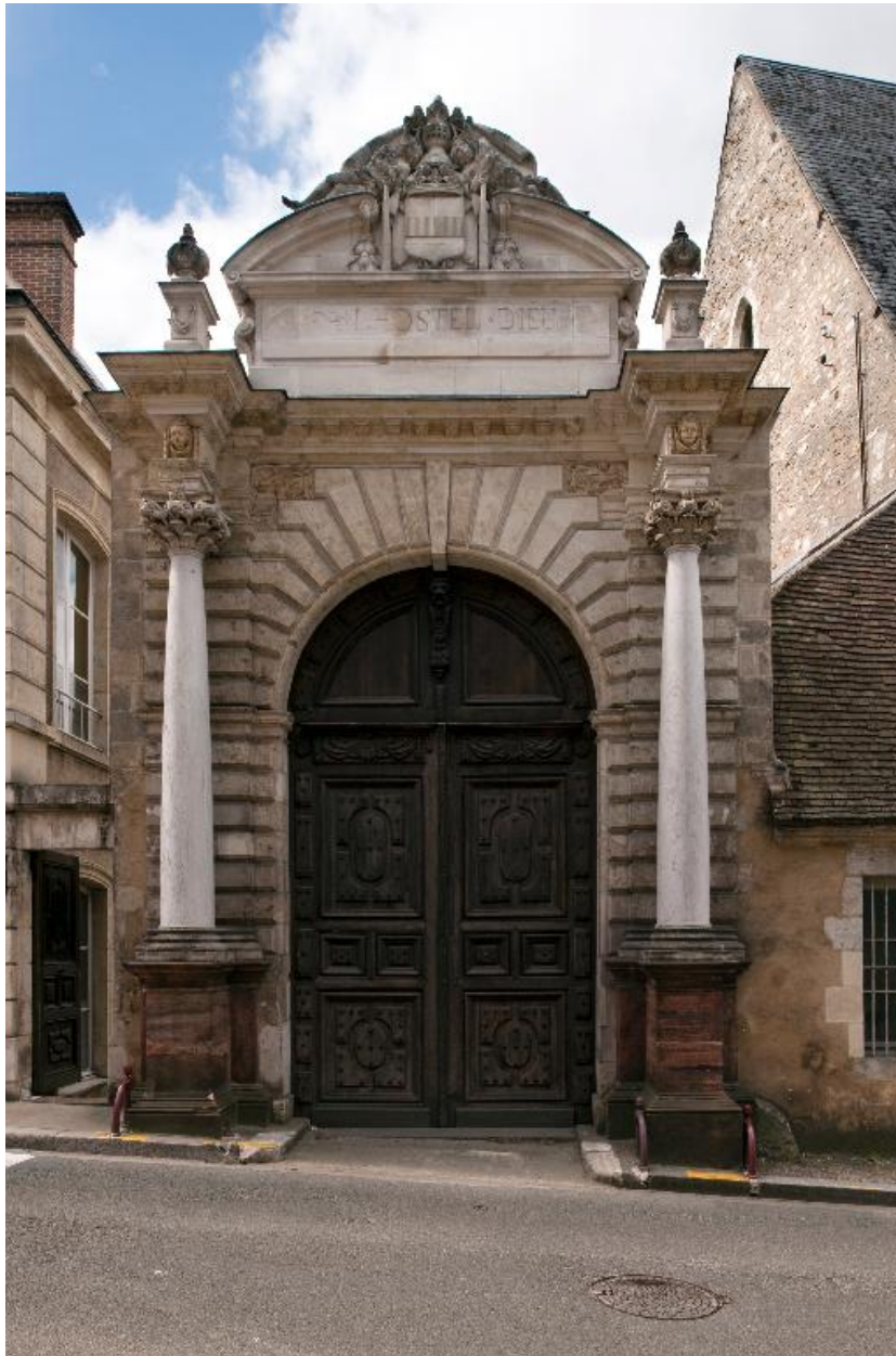
Portail de l'Hôtel-Dieu, vue du nord.
