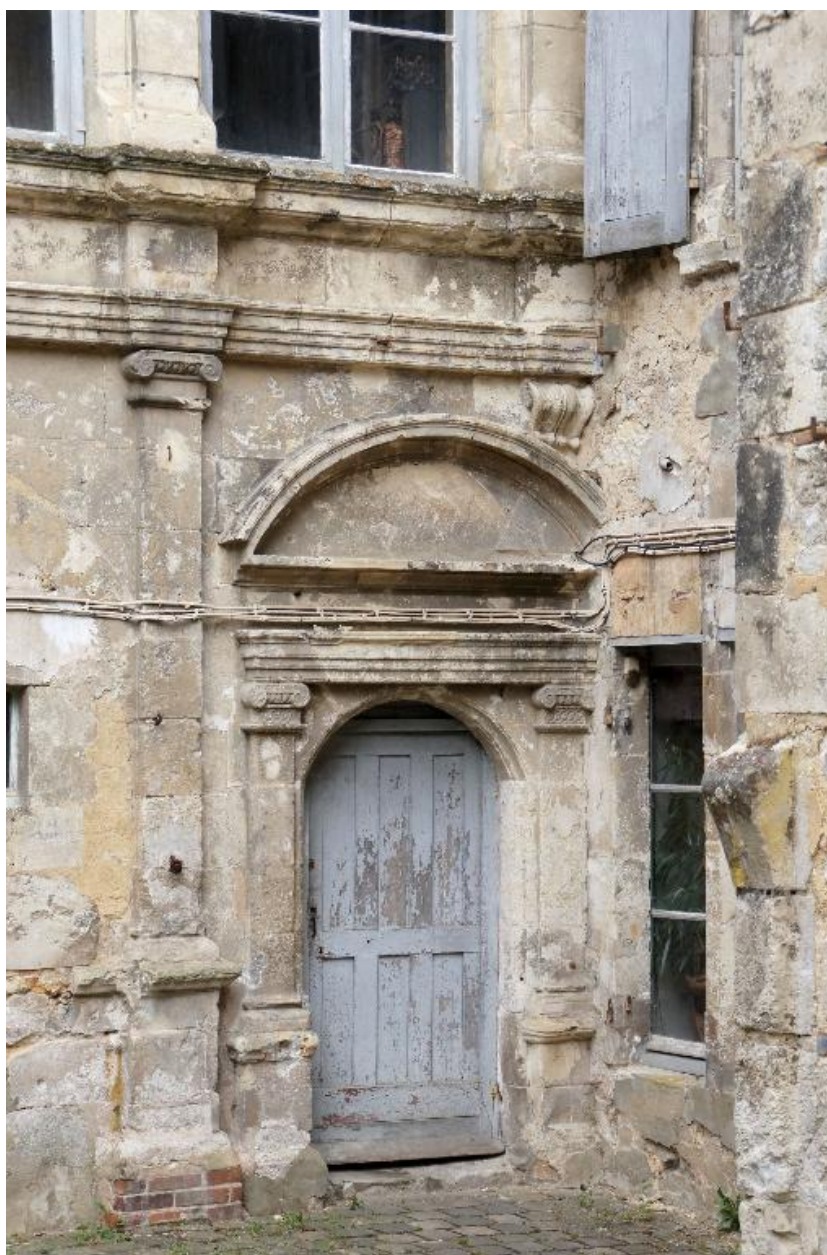
Face nord, rez-de-chaussée, détail de la porte de l'escalier.
