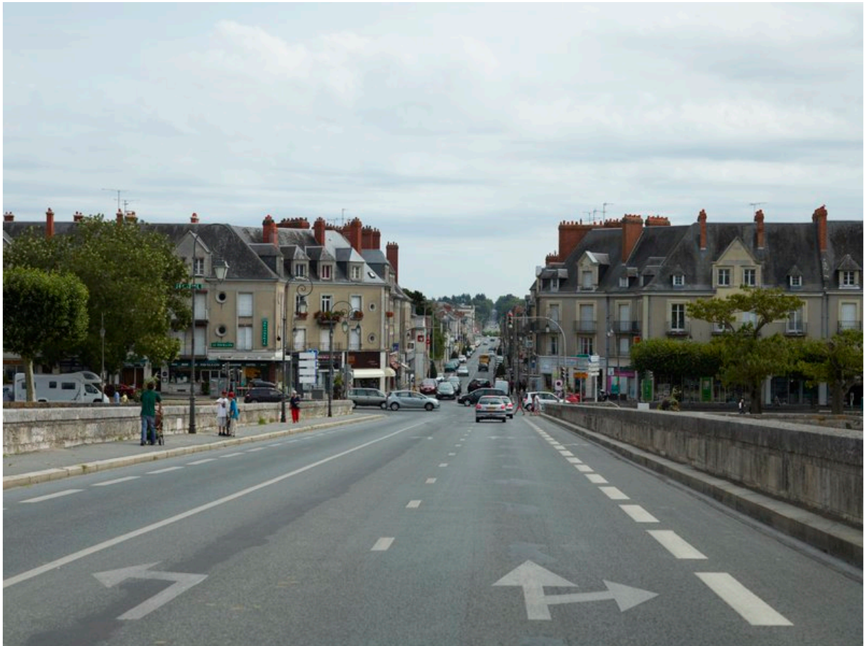
Vue générale de la tête de pont de la rive gauche.
