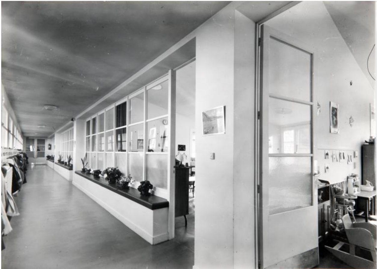
Couloir distribuant les salles de classe, 1964. (Archives municipales de Blois, 13 Z 21).
