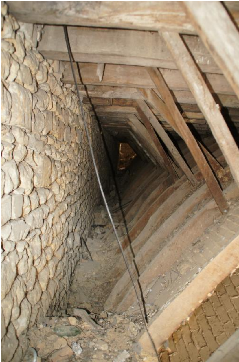
Bas-côté sud, charpente lambrissée, comble.
