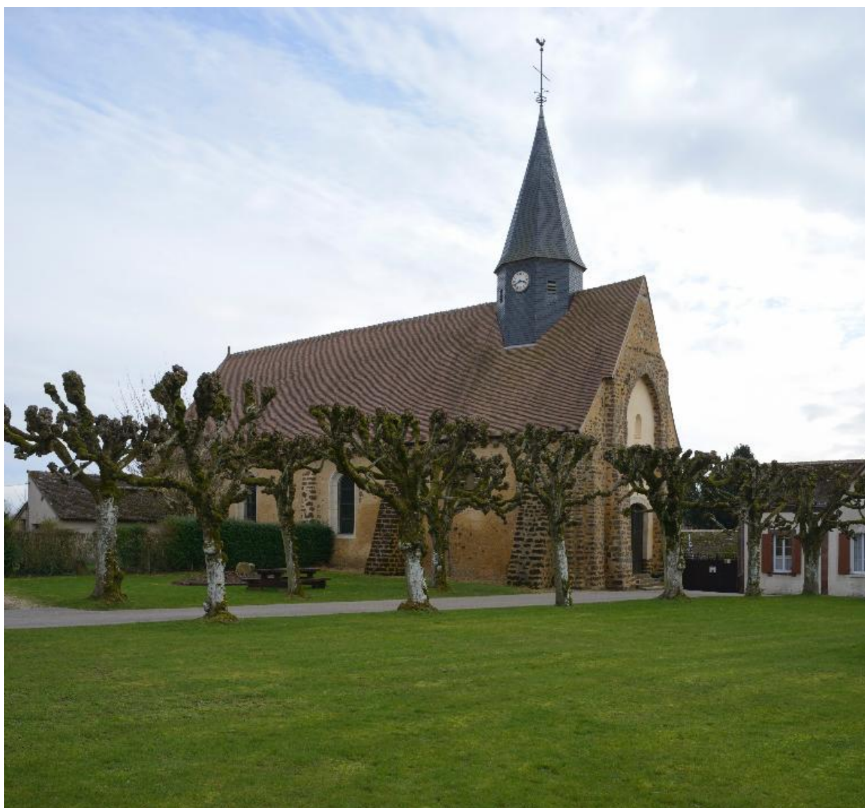
La Croix-du-Perche, église paroissiale Saint-Martin.
