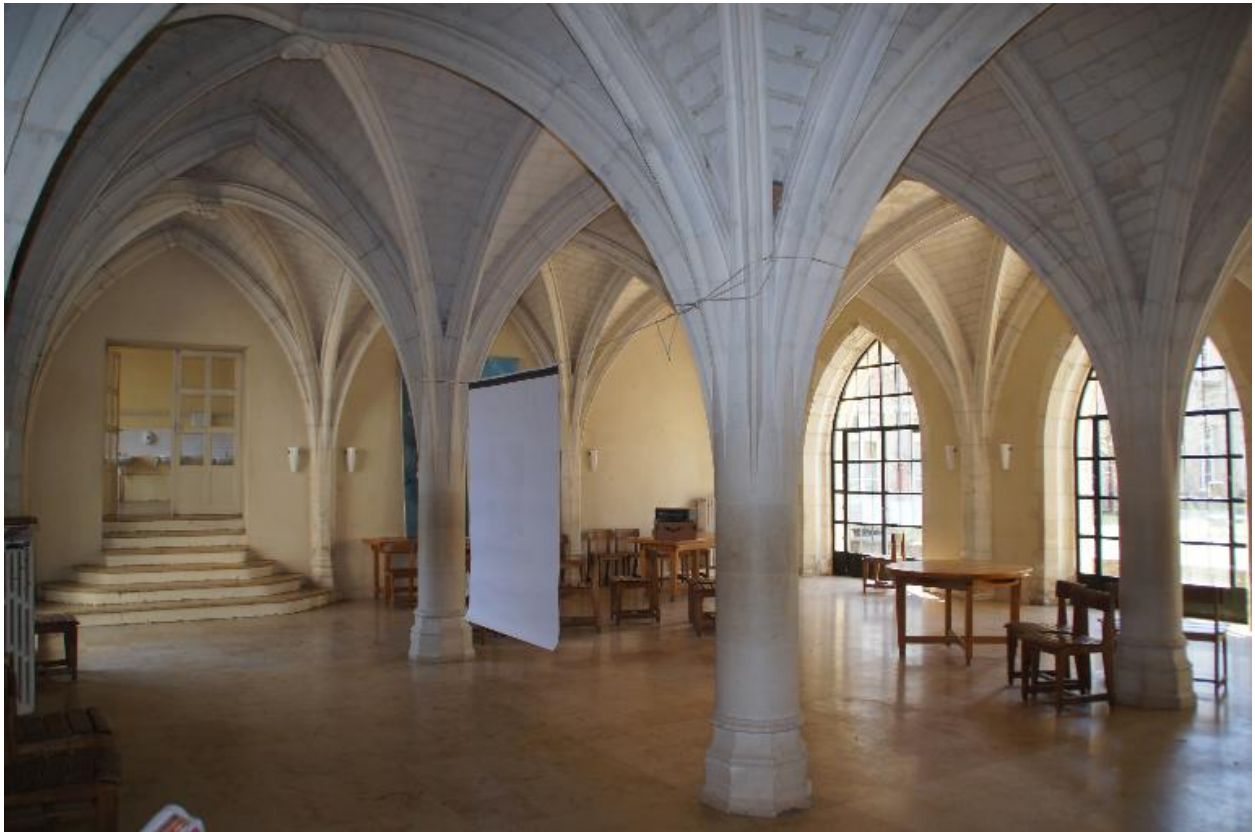
Aile est, élévation intérieure : réfectoire.
